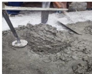
Gambar 3. Pengujian Nilai Slump
